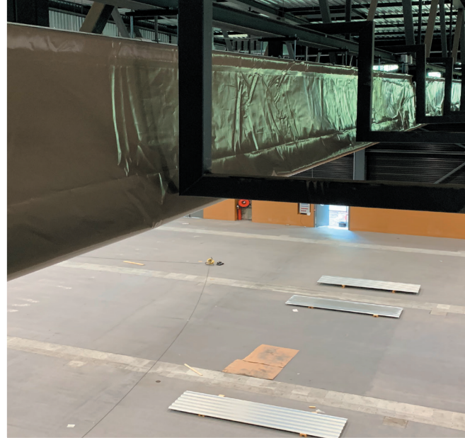
Zone de stockage
