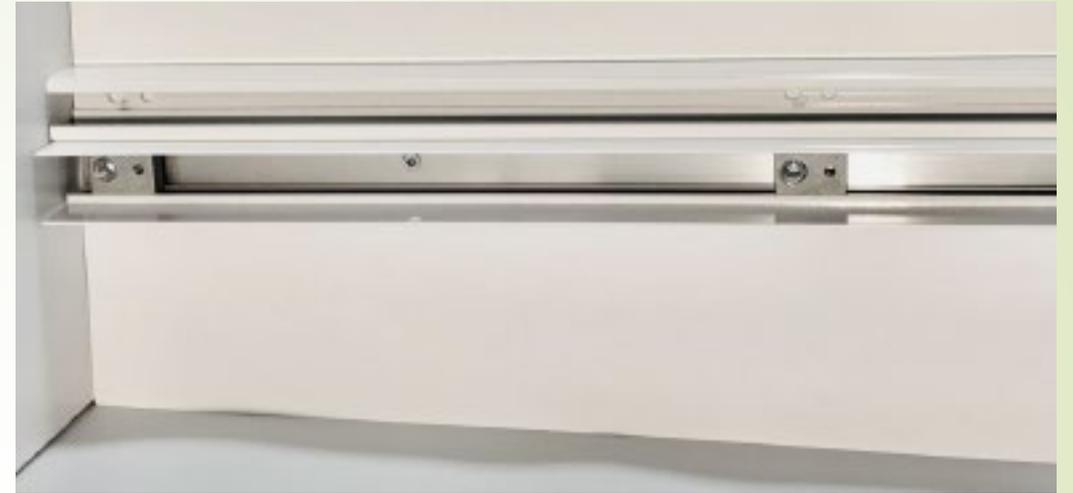
11 – Insérer la cloison dans le rail (bien vérifier le sens d'ouverture)
