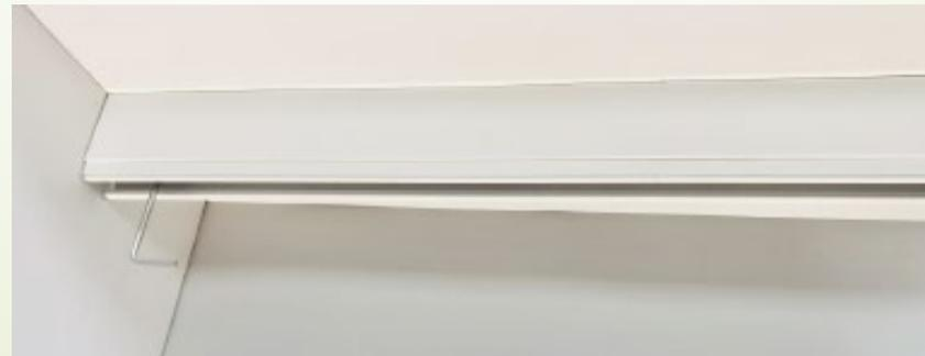
13 – Maintenant que le rail est fixé sur le plafond, visser ou dévisser les vis de réglage afin de régler la position du rail (photo ci-dessous) en utilisant les clés Allen.
